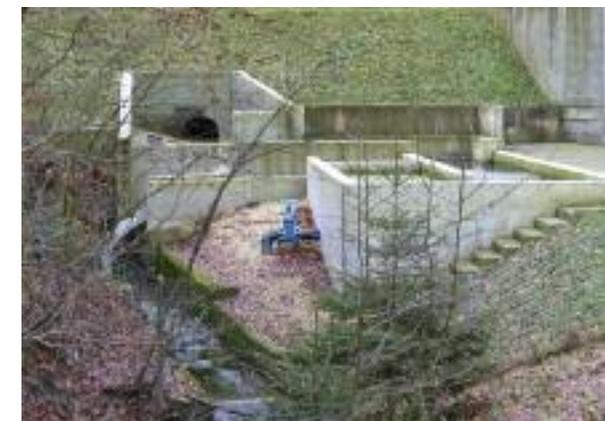
Bild1: Bach-Einlaufbauwerk am Deponiefuss
