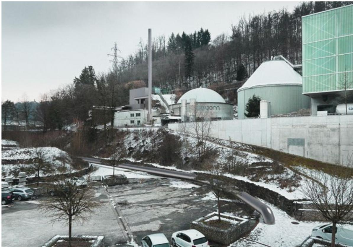
Visualisierung der geplanten Anlage mit Abluftkamin zur Elimination von Lachgas (Foto: arabern).
