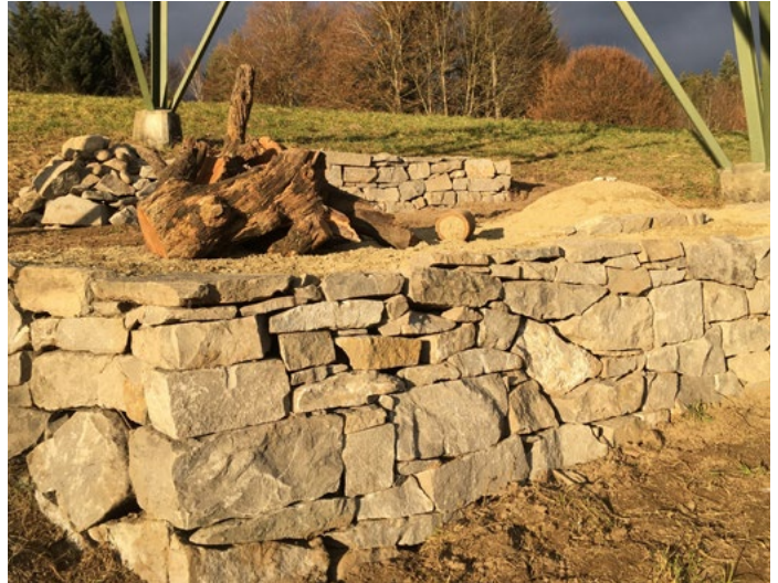
Eine Trockenmauer mit Sandlinse und ergänzenden Kleinstrukturen (Totholz und Steinhaufen). Die Trockensteinmauer dient als Stütze für die Sandlinsen und ist zugleich Unterschlupf für diverse Reptilienarten.
