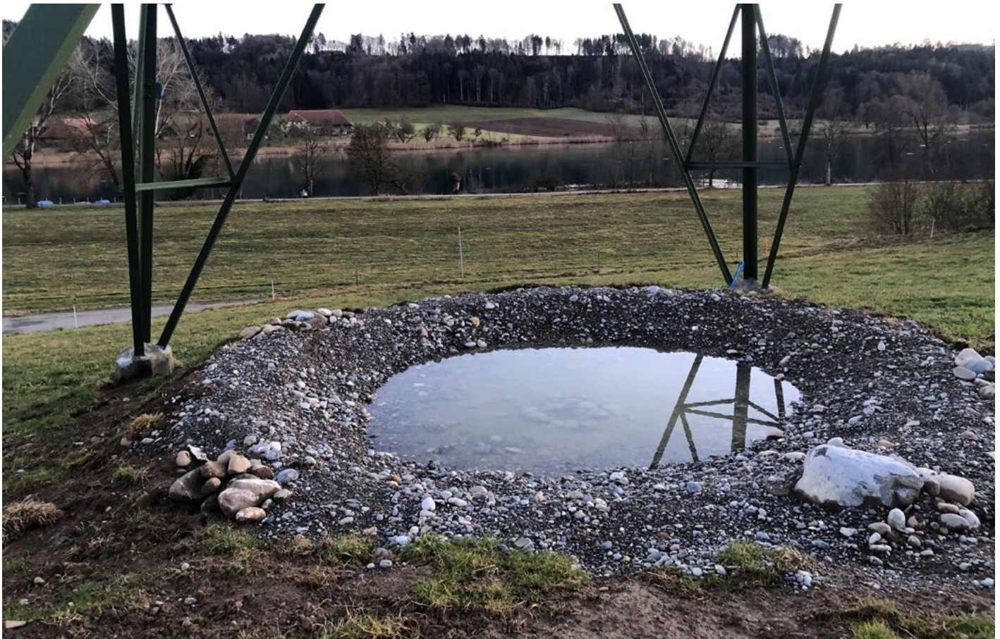
Der fertige, aber noch nicht ganz gefüllte Teich oberhalb des Wohlensees. Im Herbst wird der Stöpsel herausgezogen und der Teich vollständig entleert. Das Wasser versickert über die eingebaute Sickergrube. Mit diesem Vorgehen wird einerseits die natürliche Dynamik einer Auen-/Flusslandschaft – Lebensraum für Arten wie der Gelbbauchunke – simuliert und andererseits kann so übers Jahr gewachsene Vegetation oder Laub entfernt, sowie Folie und Vlies auf Schäden untersucht werden.
