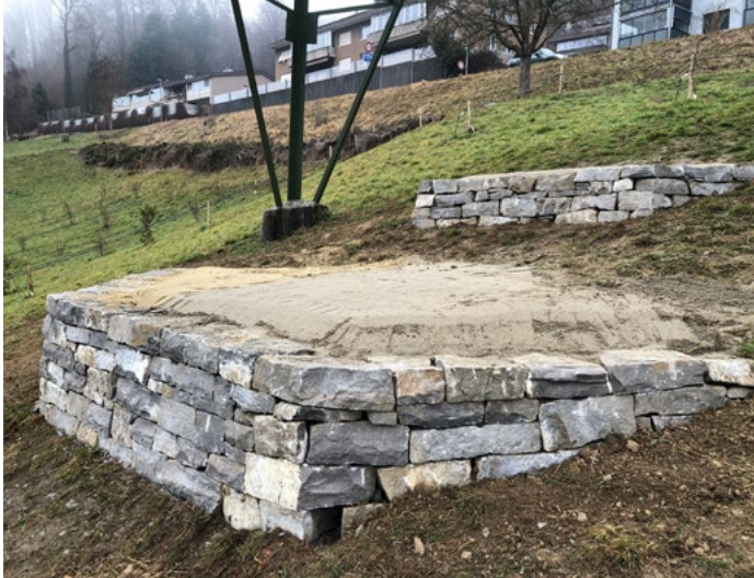
Trockenmauern mit Sandlinsen aus zwei unterschiedlichen Sandarten. Am Mauerfuss ist der Hauseingang für Hermelin und Co erkennbar.
